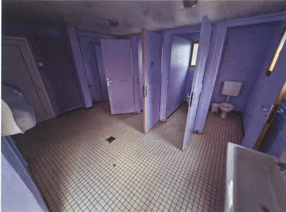
Ainsi un projet de réhabilitation de ces sanitaires a été réalisé. Il consiste à remplacer la toiture actuelle par un complexe isolant, à vider totalement les espaces et à isoler les murs, poser des sanitaires et des cloisons modernes, des chauffages performants, changer portes d'entrée et fenêtres.
