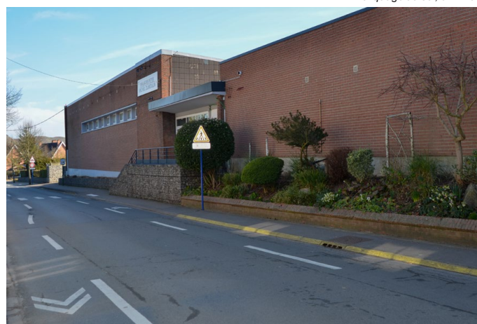
Salle des fêtes Dumoulin, changement de la chaudière
