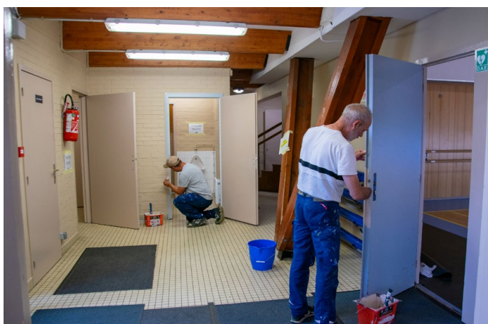
Salle Pidoux, mise en peinture du hall et des vestiaires
