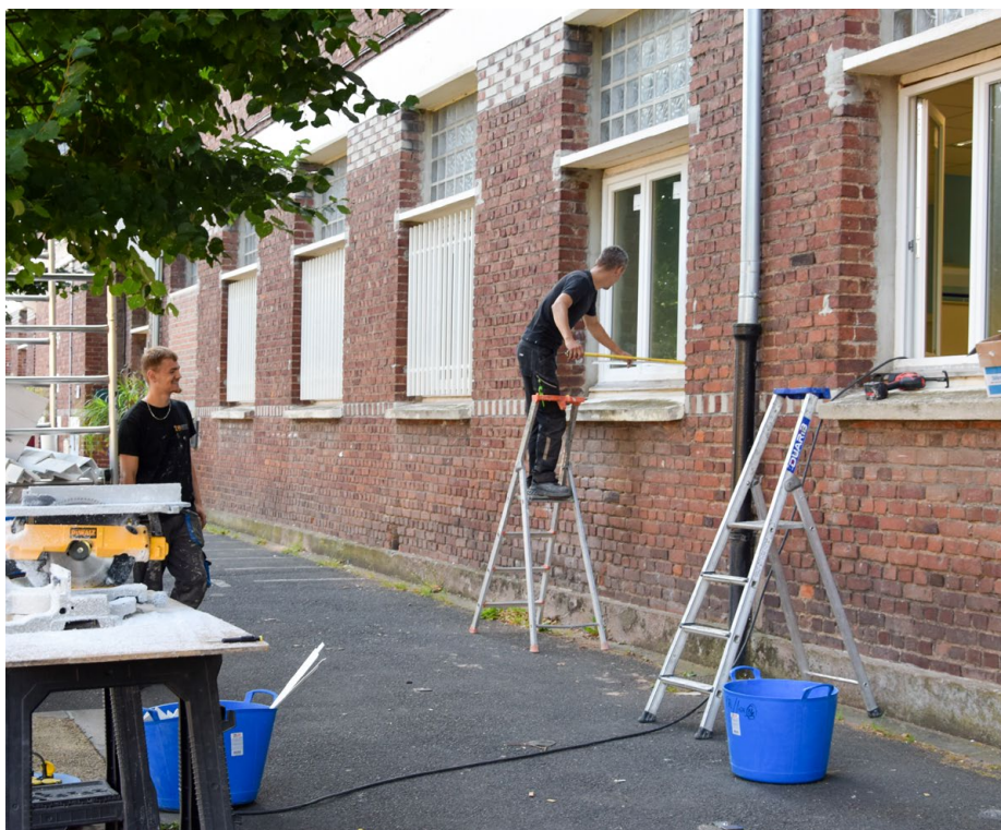
Rénovation des menuiseries à l'école Paul Vaillant-Couturier
