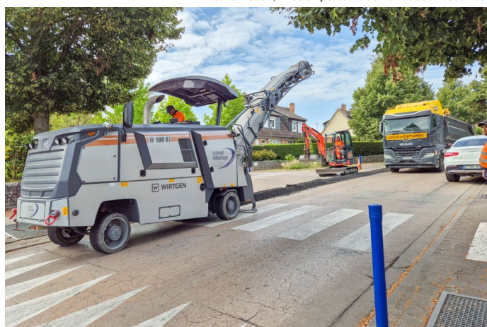
Rénovation du réseau électrique par ENEDIS, rue du Général de Gaulle
