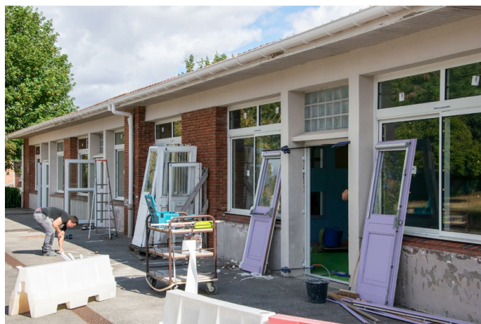
Remplacement des fenêtres à l'école Elsa Triolet
