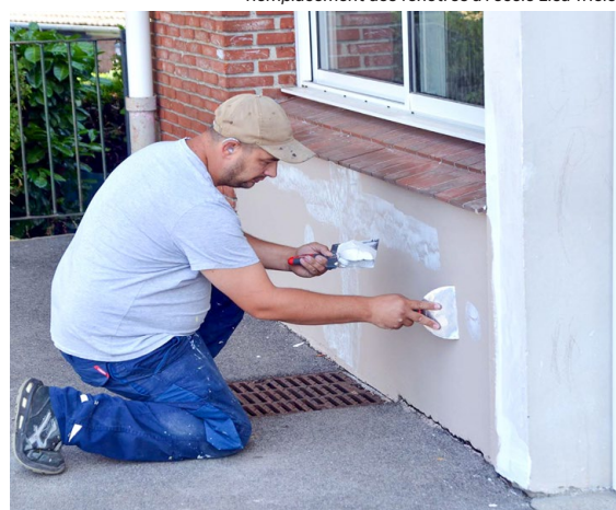
Mise en peinture de la façade arrière de l'école Elsa triolet
