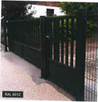
Installation des portail et portillon semi-barreaudé RAL 6012
