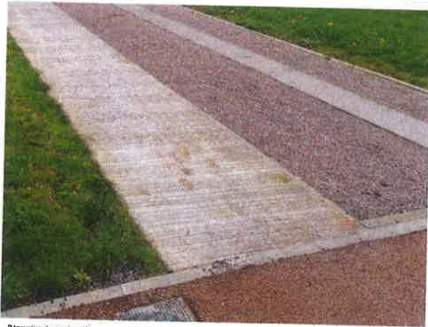
Rénovation des accès au logement en béton balayé Stationnement en bande de roulement et complément en sable stabilisé
