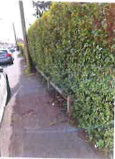
Rénovation des lisses basse béton ou installation si non existante
