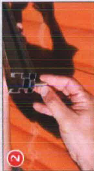
Insérer les vis dans les profils Solar-Plus
