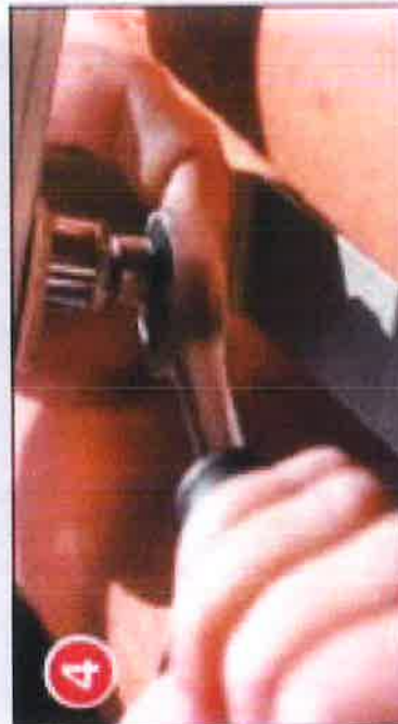
Fixer les profils Solar-Plus sur le crochet
