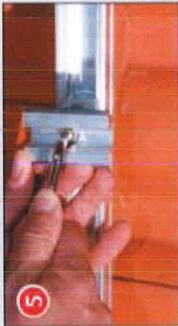
Insérer les brides PMF et PMC
