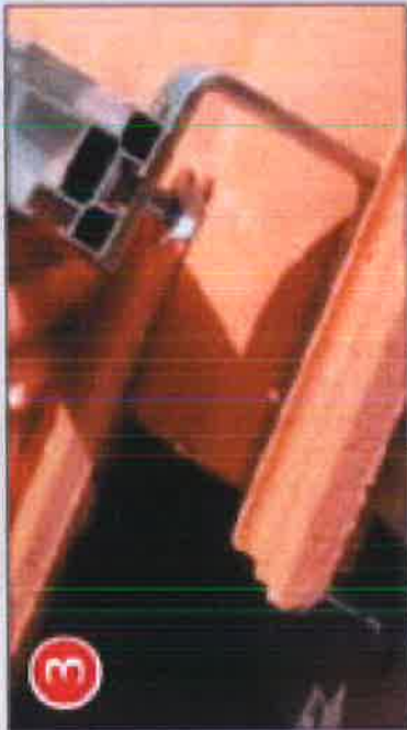
Positionner le profilé Solar-Plus sur le crochet
