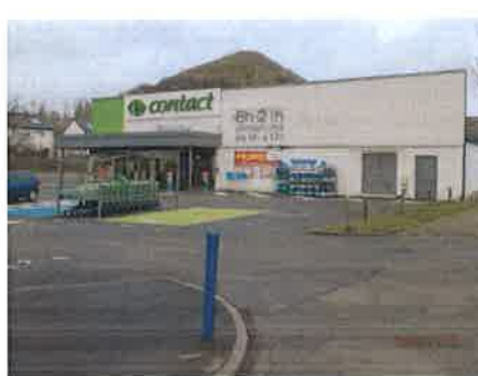
Covisibilité avec un terril classé (Ange des rues du Général de Gaulle et du carreau de la Fosse 2)
